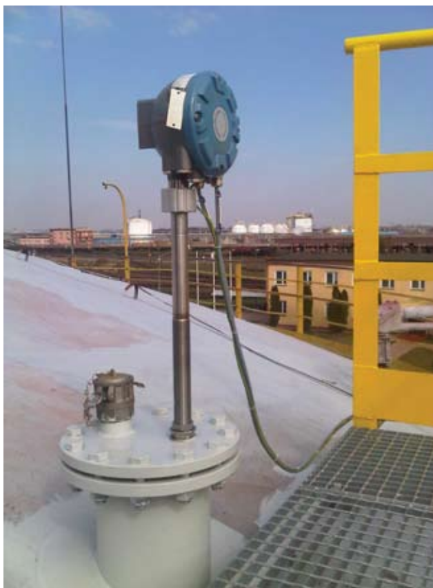
Urządzenia systemu Raptor (po lewej: Koncentrator TankHub 2410 z ochroną przeciwprzepięciową TSP, po prawej: wielopunktowa sonda temperatury czujnikiem wody dennej z przetwornikiem 2240)
