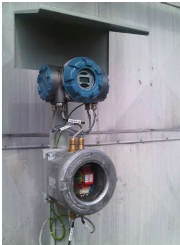
Urządzenia systemu Raptor (po lewej: Koncentrator TankHub 2410 z ochroną przeciwprzepięciową TSP, po prawej: wielopunktowa sonda temperatury czujnikiem wody dennej z przetwornikiem 2240)
