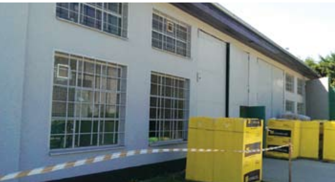
Widok budynku starej hali produkcyjnej przed remontem (czerwiec 2014)
