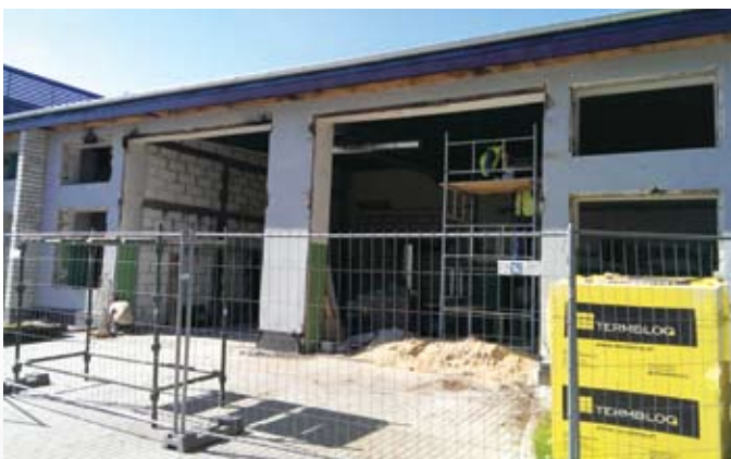
Hala produkcyjna w trakcie prac modernizacyjnych (czerwiec 2014)
