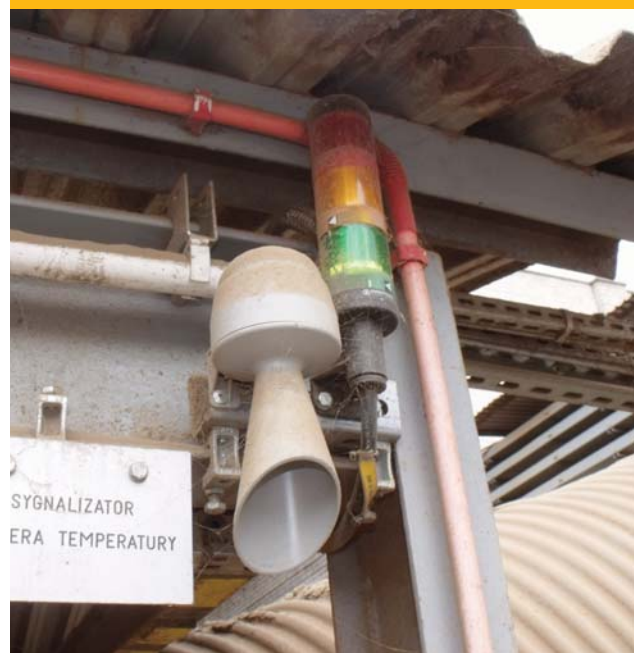
Sygnalizator świetlny oraz dźwiękowy
