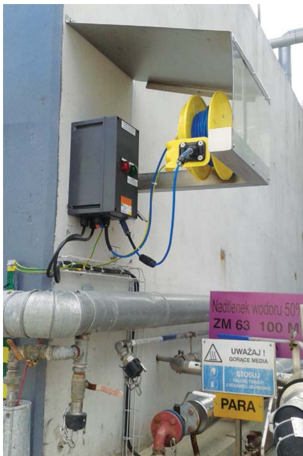
Zaprojektowany kontroler uziemienia cysterny
