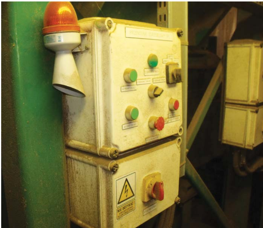
Sygnalizator świetlno-dźwiękowy
