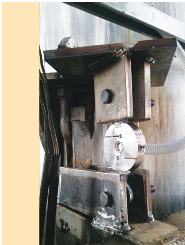
Czujnik tensometryczny w trakcie montażu
