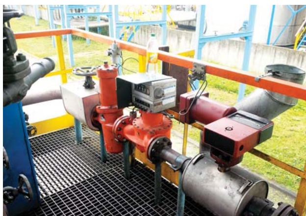
Układ pomiaru przepływu – Nalewak Auto (po lewej – przed modernizacją, po prawej – po modernizacji)
