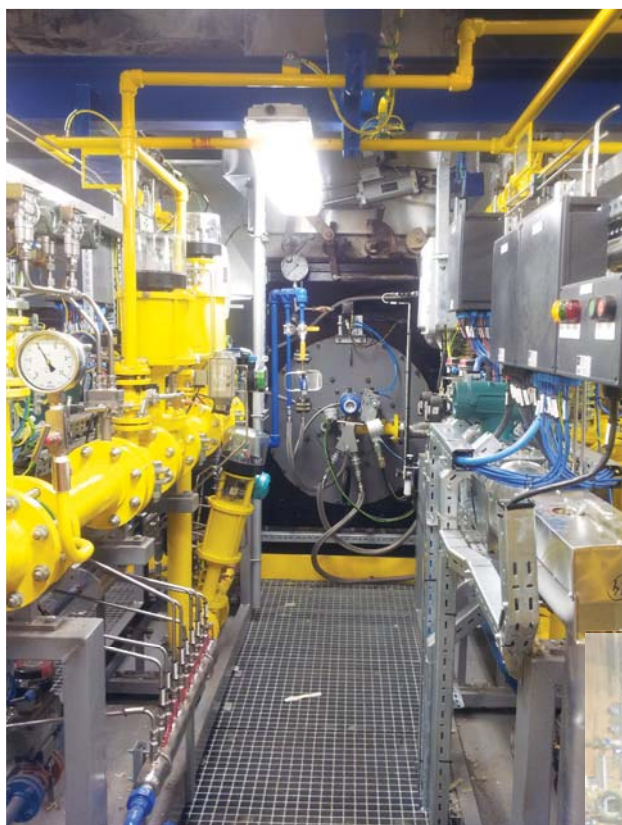
Palnik gazowo-olejowy na kotle K2
