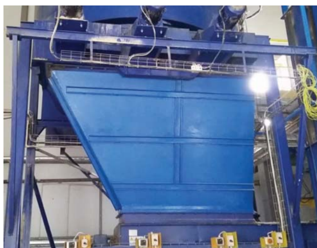
Zabezpieczony zsyp trocin nr 1 po modernizacji
