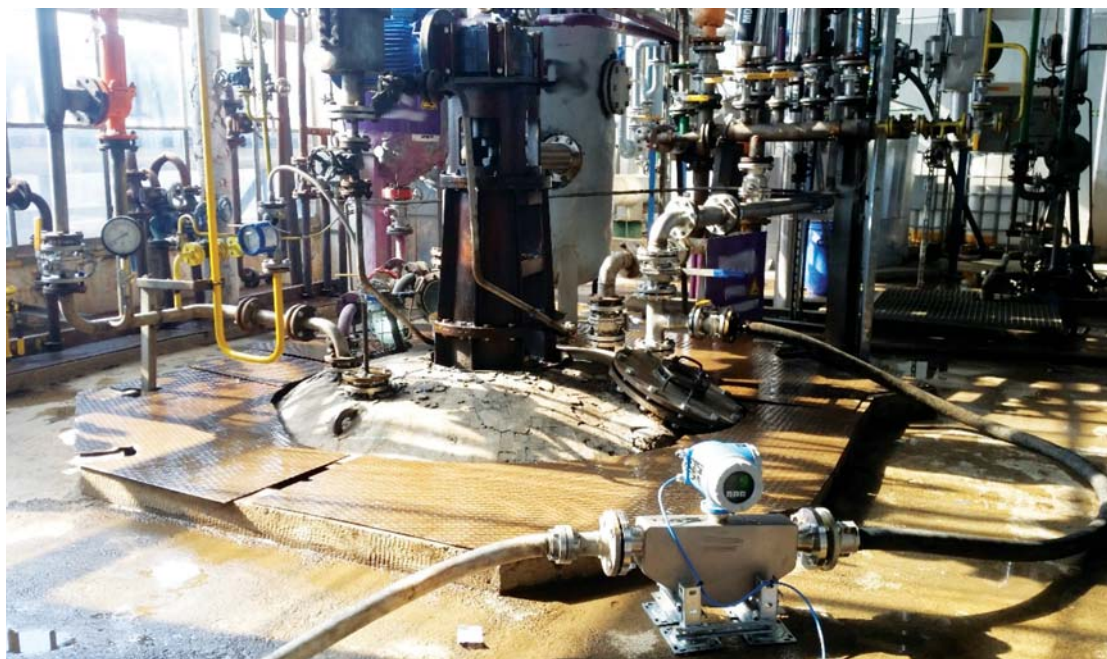
Instalacja podczas wzorcowania przepływomierzem masowym
