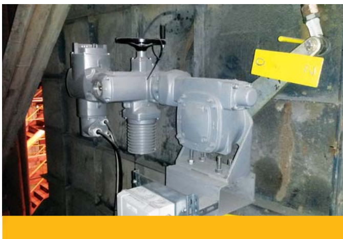
Kolumnowy napęd klap czerpni z przekładnią z ramieniem wahliwym napędem AUMA MATIC
