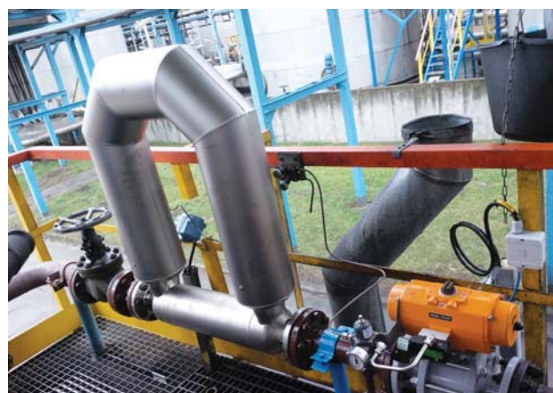
Układ pomiaru przepływu – Nalewak Auto (po lewej – przed modernizacją, po prawej – po modernizacji)
