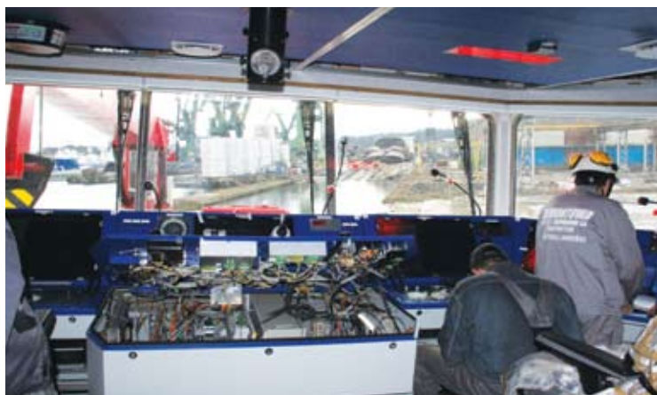
Mostek kapitański w trakcie prac wykonawczych
