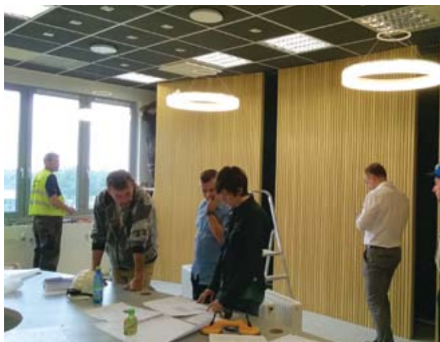
Końcowe prace wykonawcze
