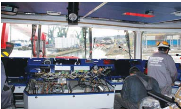
Mostek kapitański w trakcie prac wykonawczych
