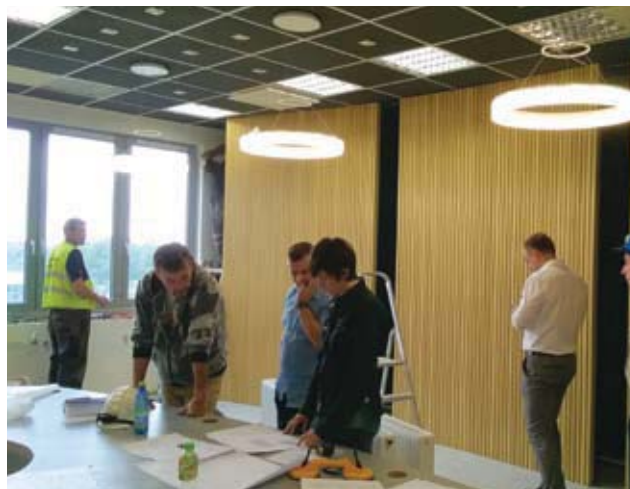
Końcowe prace wykonawcze
