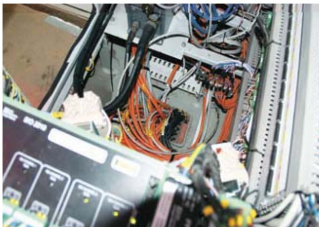
Przejście kablowe zastosowane na mostku kapitańskim.
